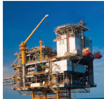
石油和天然气勘探平台 Plataforma de exploração de petróleo e gás
